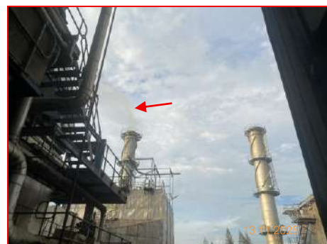
ภาพที่ 2.2-55 ตัวอย่างการ Soot Blow ปล่อง Boiler
